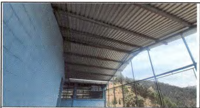
Foto 11: Instalacion de Luz Electrica
