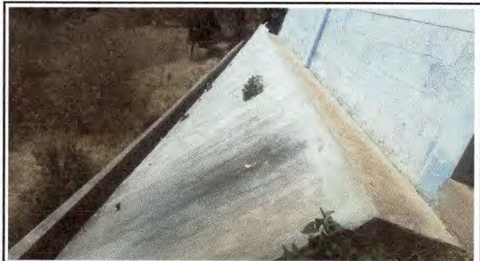
Foto 9: Pintura en muros exteriores e interiores
