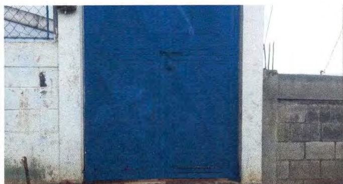
Foto 5: Mantenimiento de porton
