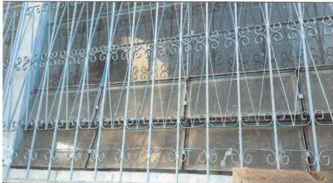
Foto 7: Mantenimiento de balcones de metal
