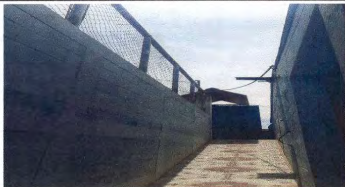
Foto 1: Sustrucion de lámina
