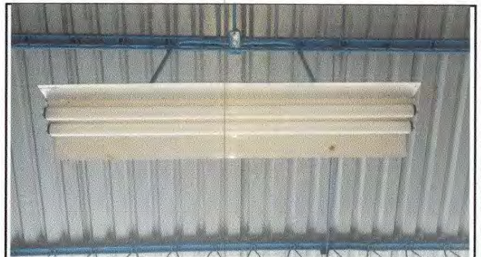
Foto 10: Sustitucion de lamparas Led 120
