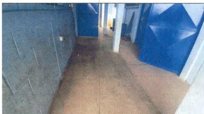
Foto 4: Sustrucion de chapas
