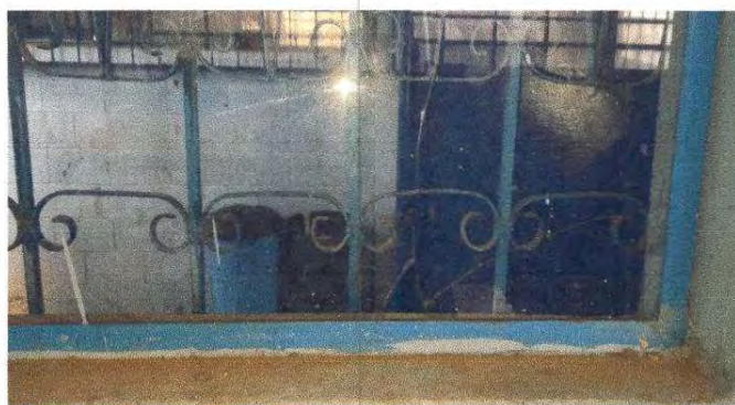
Foto 6: Sustrucion de vidrio
