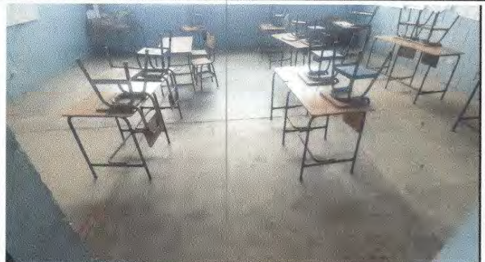
Foto 8: sustitucion de piso
