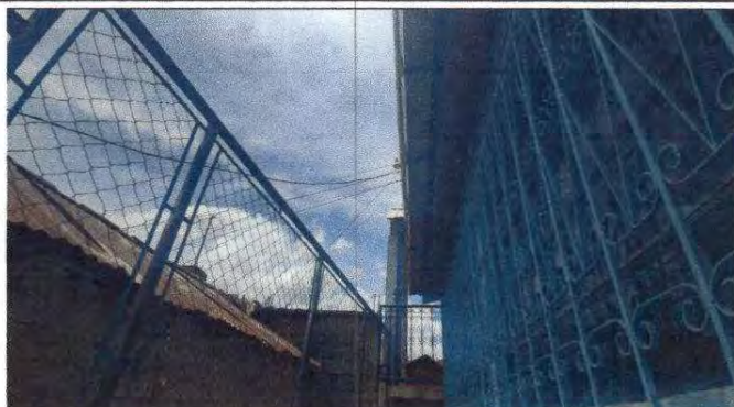
Foto 2: sustrucion de lámina
